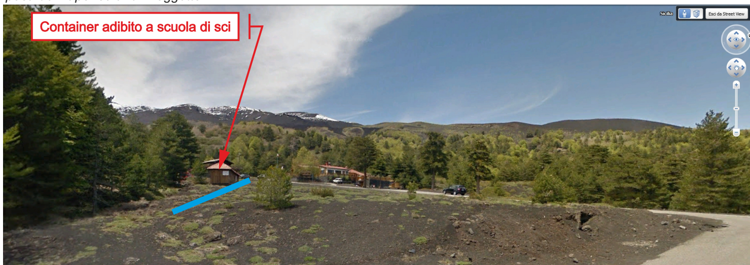
Vista da valle dell'area di interesse. Si evidenzia la presenza del container Scuola di Sci, oggi rimosso. in azzurro l'are di posa del taps rouland in oggetto
