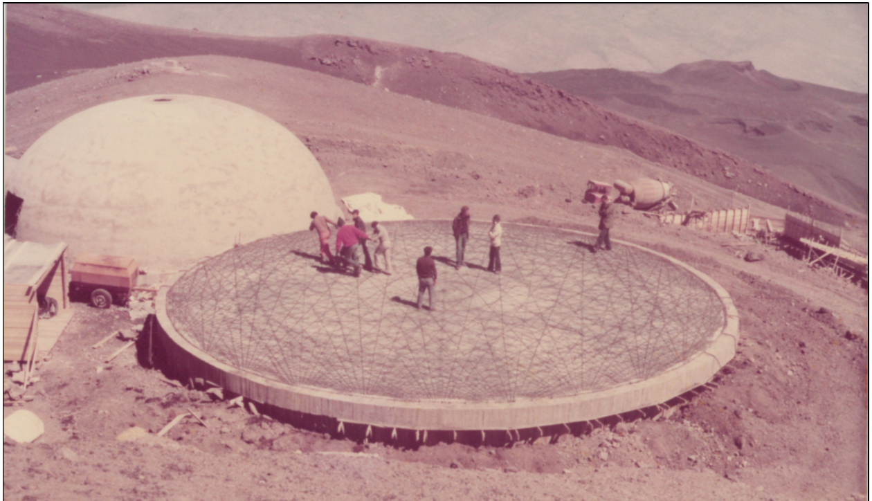
Figura 6 - Fase di costruzione delle due cupole dell'osservatorio vulcanologico di Pizzi Deneri realizzate con la tecnica Binishell (Foto archivio INGV_OE). Alla Biennale di Architettura di Venezia del 2016 la tecnica di Dante Bini fu definita una delle architetture migliori degli ultimi cento anni.
